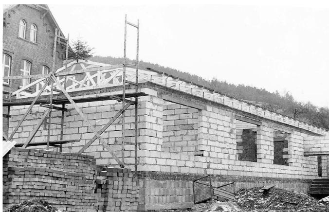
Vor der ehemaligen sachsen-meiningischen Schule entsteht in den 70iger Jahren der Rohbau der neuen Kegelbahn mit Vereinshaus.
